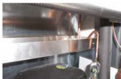
Dissipatore di condensa di serie su tutta la gamma. Condensate evaporator as standard on the whole range
