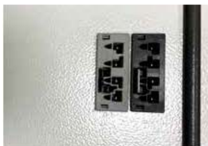
Gestione a morsettiera degli allarmi, ON/OFF remoto (micro-interruttore apertura porta) e RS485 collegamento seriale con controllo remoto fino a 32 unità sulla versione TOP.
